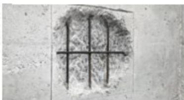
puente de unión / anticorrosión
