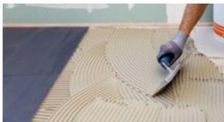
Para aplicaciones convencionales, aplicar el adhesivo por simple encolado mediante llana dentada. En exteriores y/o zonas con humedad permanente, aplicar el adhesivo por doble encolado.
