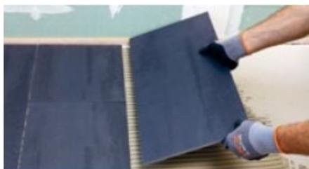
Colocar las piezas cerámicas sobre el adhesivo aplicado ejerciendo una ligera presión, asegurando el completo contacto de la pieza con el adhesivo.
